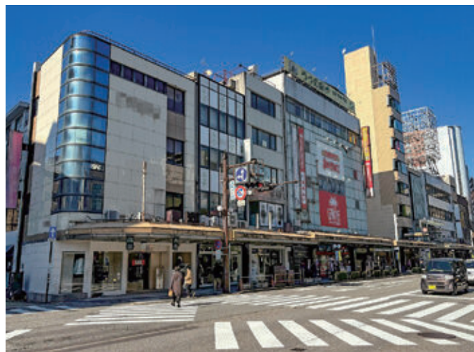
片町四番組海側地区の再開発に向けた実施設計等を支援します
