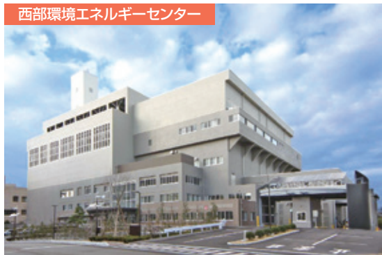
西部環境エネルギーセンター
