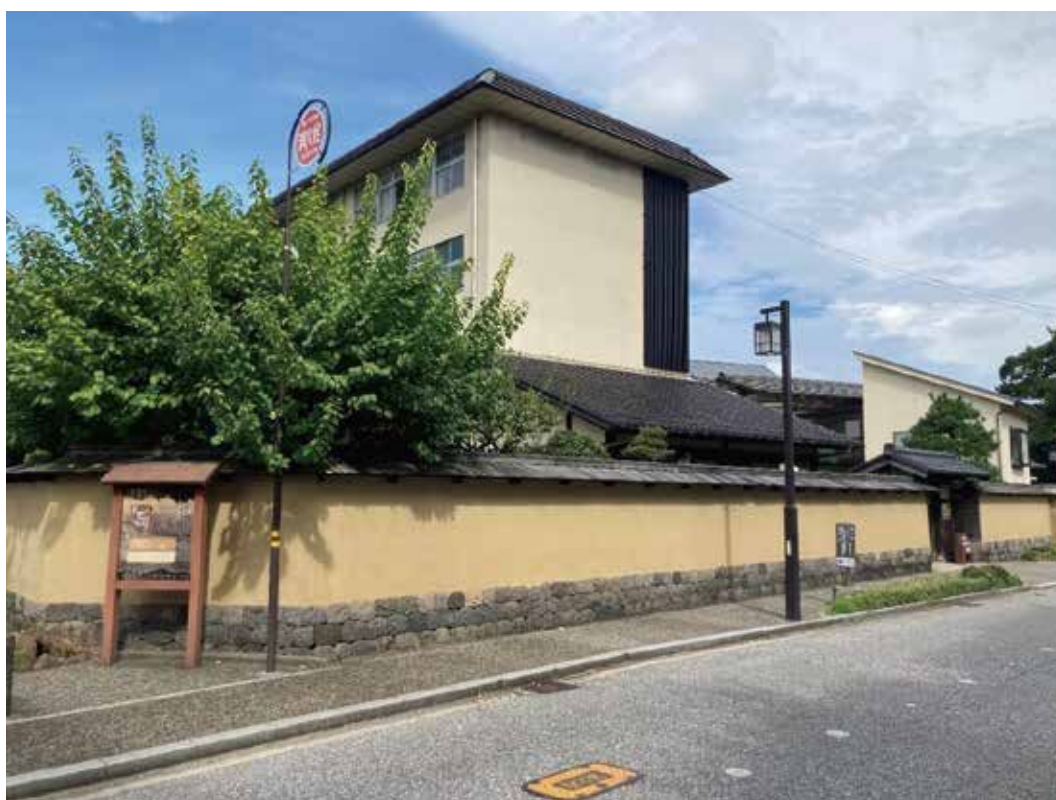
大野庄用水沿い 一の橋付近（上段古写真：岸川家所蔵）
