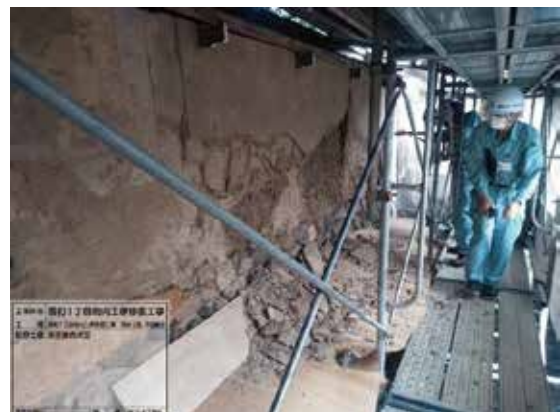
仕様調査後、劣化した土壁を取り除き、修復の範囲を確認する
