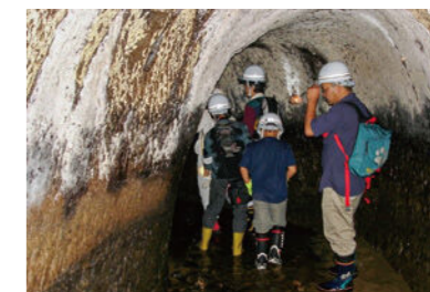
トンネル（がけの下を通る水路）
