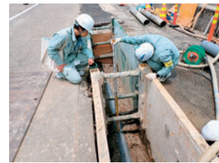
下水道復旧工事
