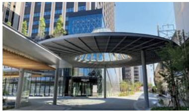
金沢駅西広場の再整備
