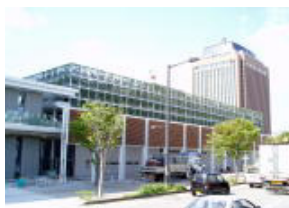
屋上や壁面が緑化された建築物
