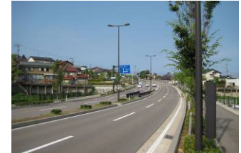
金沢外環状道路山側環状
