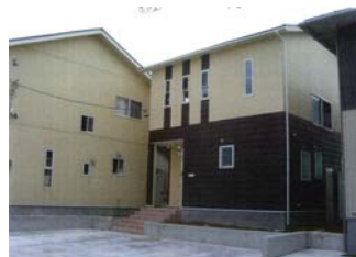
伝環区域内の総二階建ての建築物
