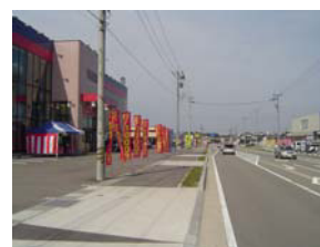
景観上支障となっているのぼり旗の林立
