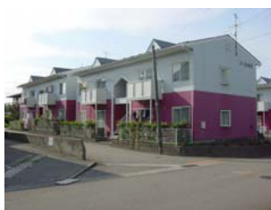
色彩のコントラストが大きな建築物
