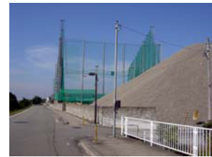
周辺景観に大きな影響を与える土砂堆積場
