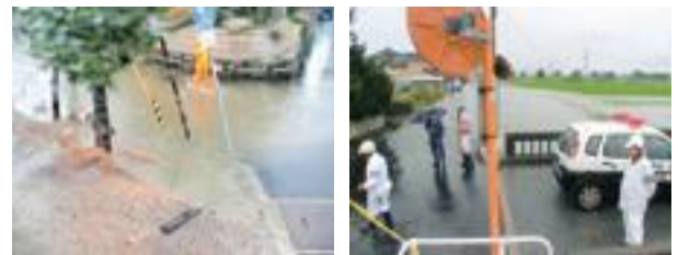
松寺町の道路冠水の様子
