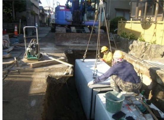
雨水管渠埋設状況
