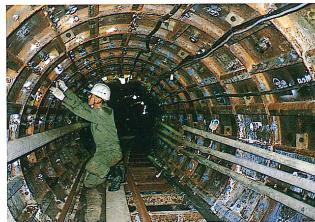
幹線工事 (シールド工法)
