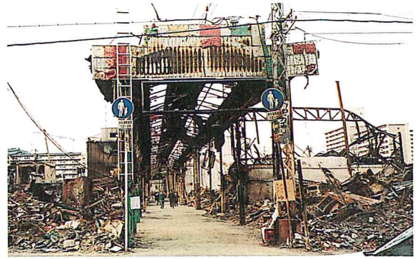
商店街の火災焼失の状況 (兵庫県南部地震)
