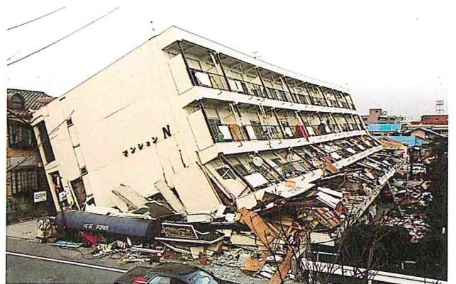
5階建マンションの崩壊(兵庫県南部地震)
