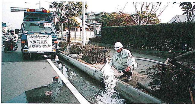
水道管の仮布設（兵庫県南部地震）
