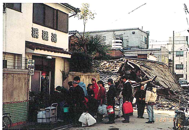
銭湯での給水の様子（兵庫県南部地震）
