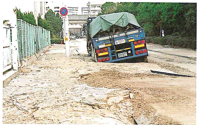
液状化によりめりこんだトラック(兵庫県南部地震)
