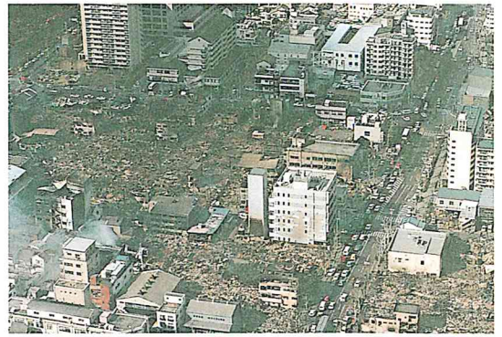
火災による焼失の状況（兵庫県南部地震）
