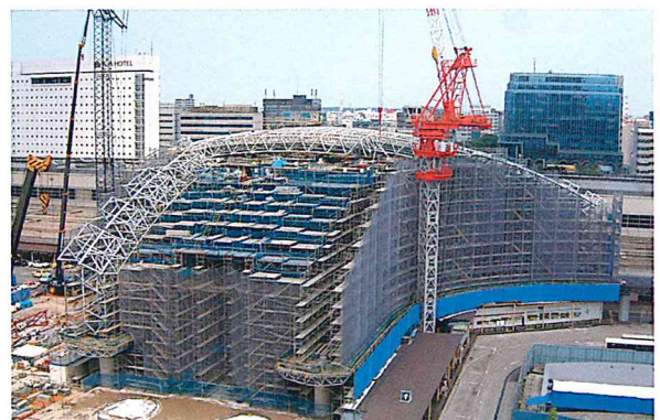
図5 ドーム足場とフレーム組立中(平成15年6月撮影)
