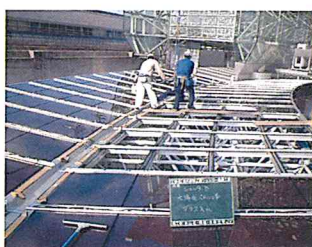
■平成16年10月 シェルターの駆体工事が完了し、太陽光パネルが設置される。
