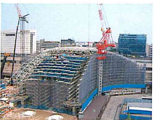
■平成15年6月 大屋根の壁面の組み立てが終わり屋根工事にかかっている。
