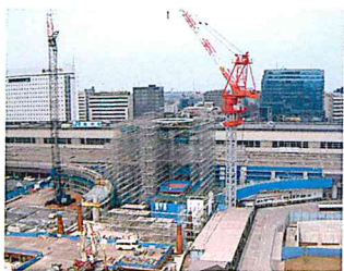
■平成15年2月末 2月6日にタワークレーンが設置され、大屋根施工が始まる。
