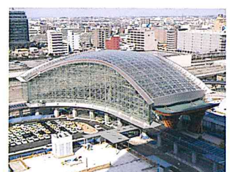
■平成17年2月中旬 一般駐車場など一部を除き工事が終了し、植栽工事が始まる。
