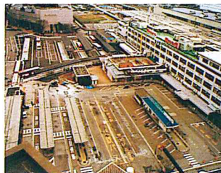
■着工時(平成10年3月頃) 一般車の乗り入れが出来なくなり、タクシープール、乗り場の移動が始まる。
