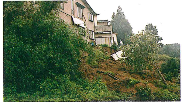
平成8年6月 集中豪雨によるがけ崩れ（金沢市内）
