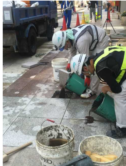
▼舗装改良の様子
