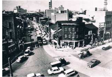
▼昭和41年頃の武蔵(武蔵商店街HP)
