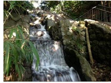
マイクロ水力発電設備が設置された本多公園（発電出力は最大1kW）
