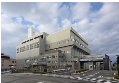
西部環境エネルギーセンター
