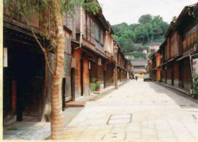
延長 176m *電線類地中化 整備年度 H5年度
