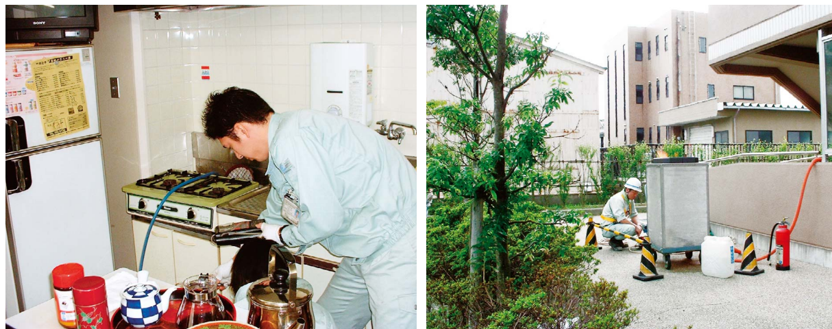
熱量変更作業（室内作業と室外作業）
