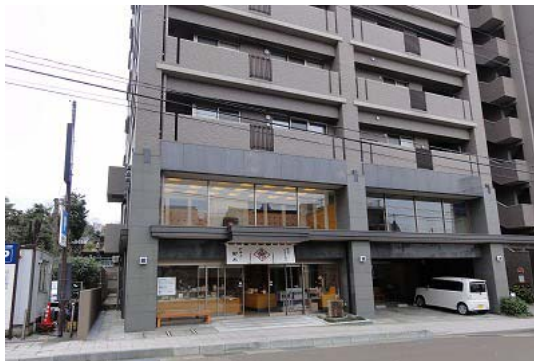
マンション低層部の商業利用事例
