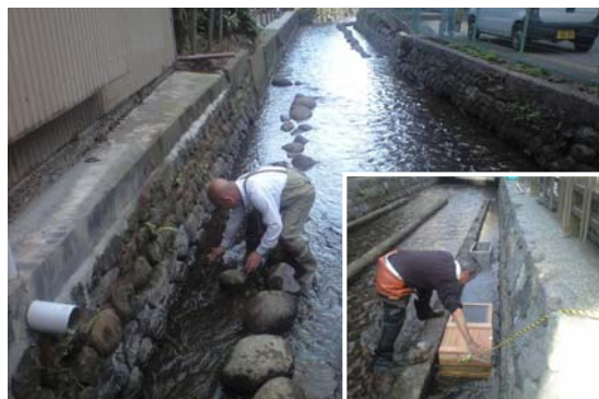
大野庄用水のホタルの生息に配慮した整備事例 既存の石積護岸を保全し、河床にホタルの餌であるカワニナが生息しやすいよう玉石を設置。 写真は地元住民がホタルの餌であるカワニナを放流している様子。
