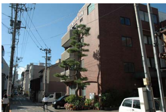
建物前面に植栽された松
