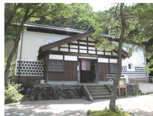
旧金沢城内土蔵：金沢大学の旧城内キャンパスにあった倉庫を移築したもので、当初の建築は大正11年(1922年)、旧陸軍第九師団の倉庫として建てられたといわれています。外壁の「なまこ壁」の装飾は、昭和47年(1972年)の移築の際に施されました。
