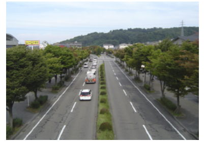
金沢外環状道路（山側幹線）
