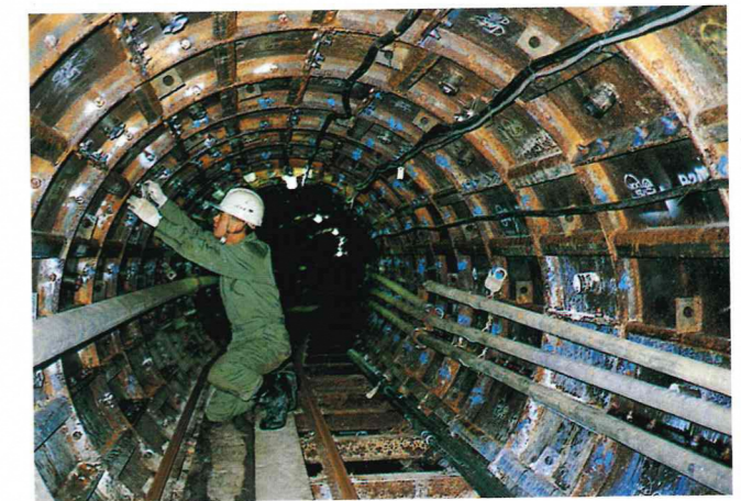
幹線工事(シールド工法)
