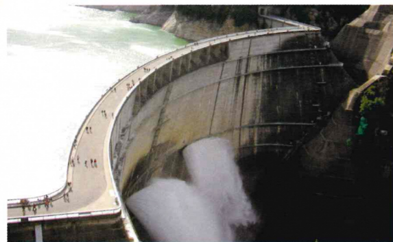
高さ日本一のアーチ式コンクリートダム
