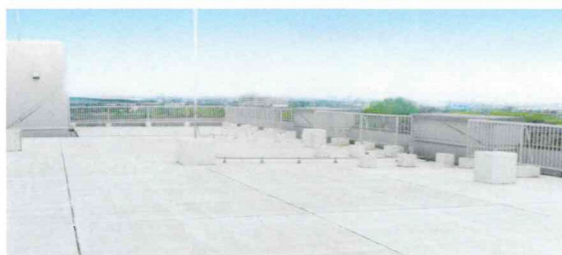
○左下：屋上の遮熱塗料 / ○右下：ソーラーLED外灯
