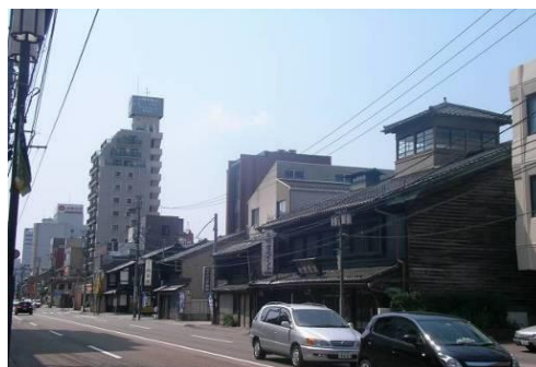
高層建築による高さの不調和
