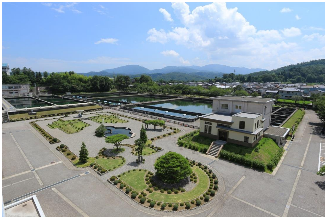
整備された前庭ならびに旧着水井上屋
