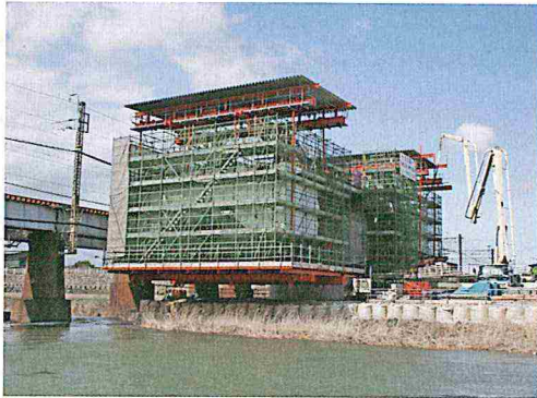
建設が進む北陸新幹線（加賀犀川橋梁）
