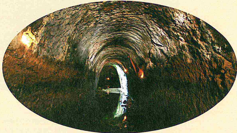
修復に向けた調査を実施する辰巳用水の隧道
