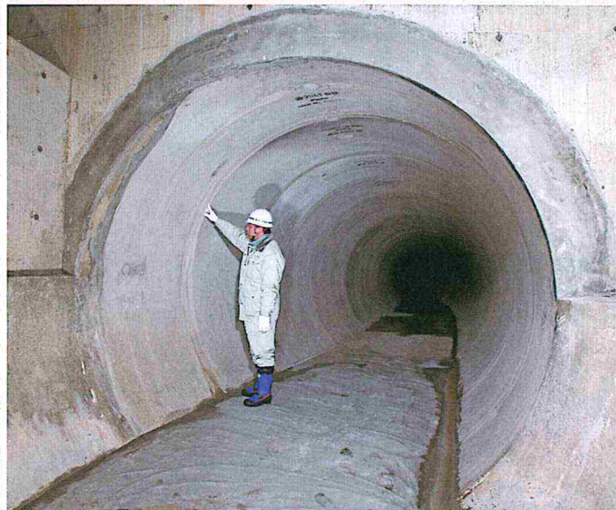
下水道雨水幹線の築造を推進します
