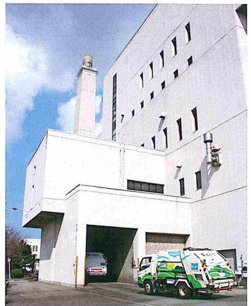
新工場の建設に着手する西部クリーンセンター
