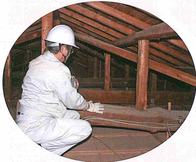
木造住宅の耐震診断
