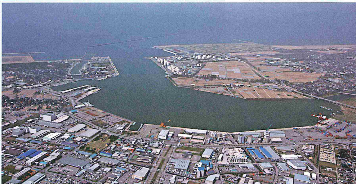
大水深岸壁の整備が進む金沢港
