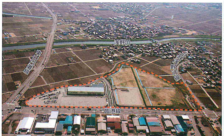
かたつ工業団地造成区域
