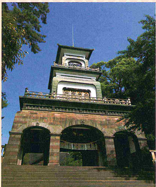
尾山神社前辰巳用水の開渠化に着手します
