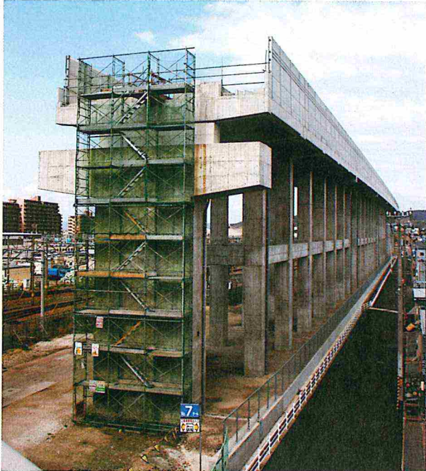
建設が進む北陸新幹線高架橋
