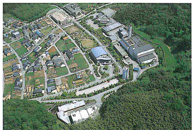
基幹的改良事業に着手する東部クリーンセンター
