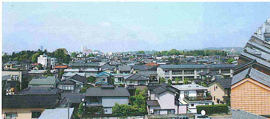
住環境保全型の地区計画導入地区（泉野町3丁目地区）
