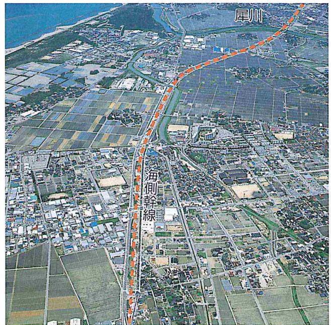
側道が全線開通する海側幹線
