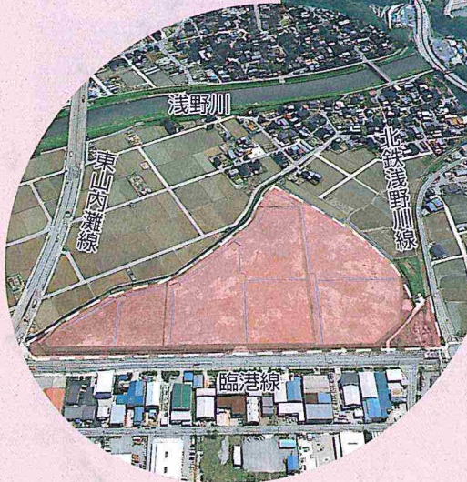
かたつ工業団地（蚊爪周辺地区）造成区域
