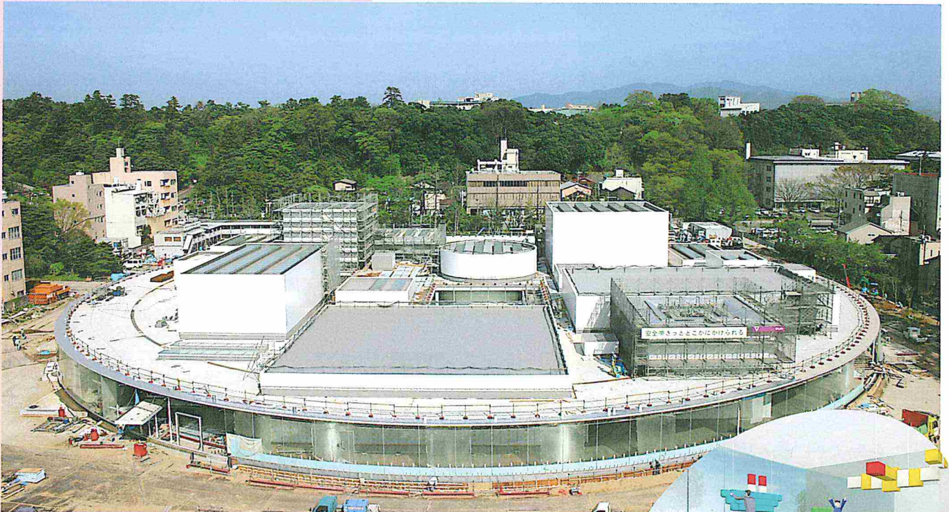
10月9日のオープンに向け建設が進む金沢21世紀美術館
