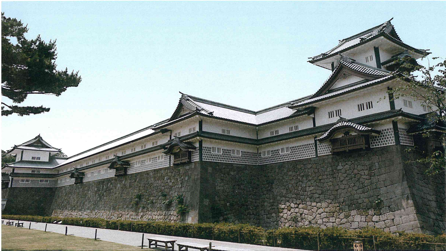
鉛瓦や海鼠(なまこ)堀の外観が美しい菱櫓と五十間長屋。金沢城公園のシンボルとして平成13(2001)年に復元された
