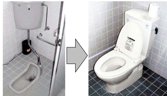
洋式便器等への便器の取替
