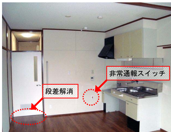
段差の解消、非常通報スイッチの設置
