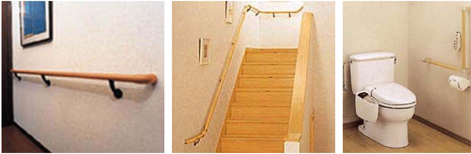
手すりの設置
