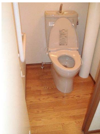
暖房便座の設置
