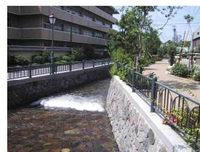
保全指定区間のうち未整備区間である L=約 85m 区間において、開渠化と老朽化した石積み護岸の整備を行う。
